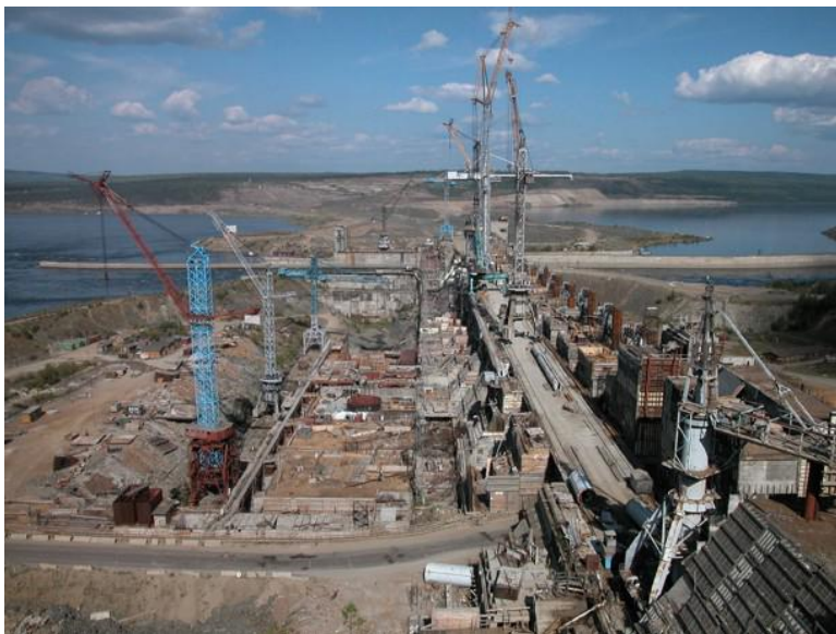
Стройплощадка Богучанской ГЭС в начале 2000-х годов
